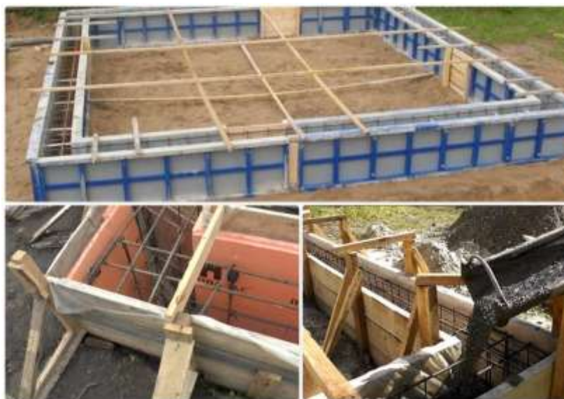
Рисунок 4. Установка опалубки для фундамента
